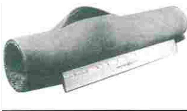
شکل ۱: لوله شکافته شده بویلر
