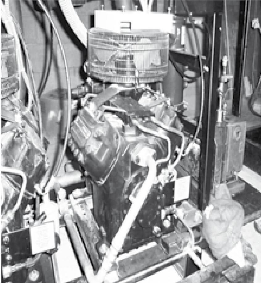
در هنگام اندازه‌گیری شدت جریان اطمینان حاصل کنید که آنچه اندازه‌گیری می‌کنید، فقط شدت جریان مصرفی توسط کمپرسور است. بدین منظور محلی را از روی نمودار سیم کشی انتخاب کنید که کمپرسور را سایر بارهای سیستم از قبیل موتور فن تقطیع مجزا شده باشد. اندازه‌گیری شدت جریانی که از کمپرسور عبور می‌کند، برای بررسی صحت عملکرد کمپرسور از اهمیت بالایی برخوردار است.
